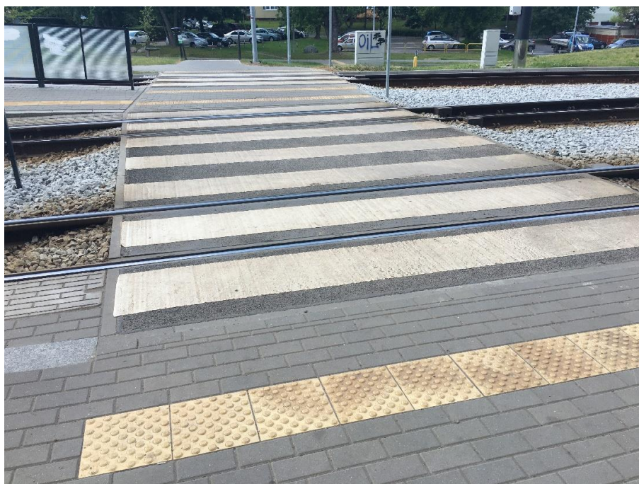
Rysunek 6. Przejście przez torowisko - pasy ostrzegawcze, brak nierówności
